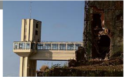
Até a derrubada completa do imóvel, a via da ladeira ficará interditada
