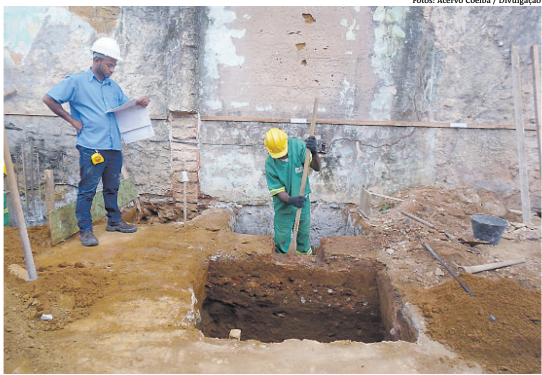
Operários trabalham em escavações para aterramento de fiação aérea na região
