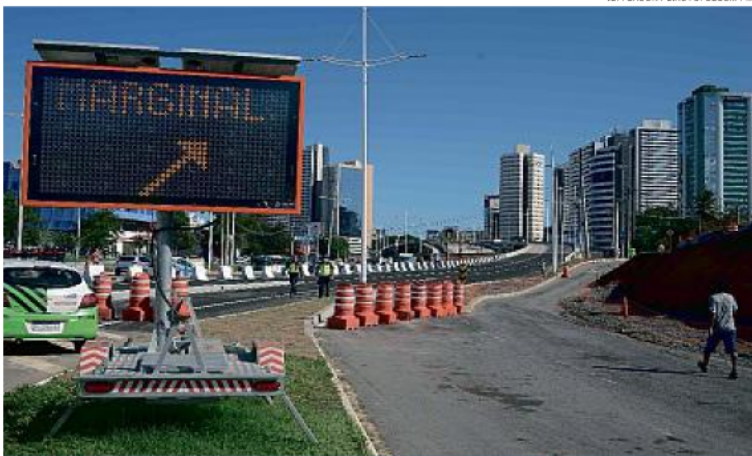
Novo elevado será utilizado pelos motoristas que vão no sentido do Parque da Cidade
