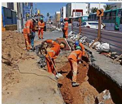
Obras no trecho entre Amaralina e Pituba devem durar 12 meses
