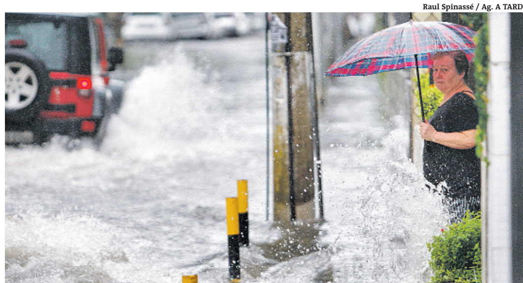
Transeunte enfrenta situação crítica na rua Arthur Gomes de Carvalho (Pituba)
