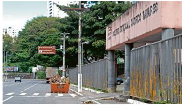
O Colégio Odorico Tavares tem duas entradas: no Vale do Canela e no Corredor da Vitória
