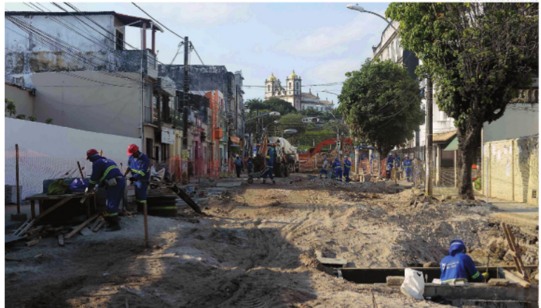
As melhorias serão realizadas no percurso de 1,1 km da Avenida Dendezeiros
