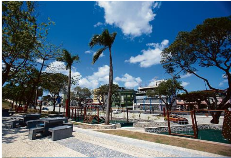
Obras de Requalificação do Largo da Baixa do Bonfim foram entregues à população na sexta-feira pela Prefeitura de Salvador
