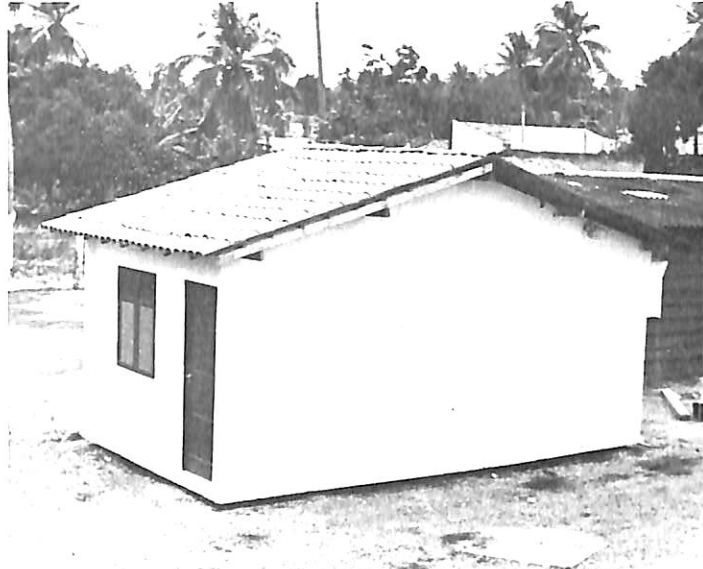
Pesquisando a sua tecnologia de fabricação de placas pré-moldadas, a Construtora J. Lessa Ribeiro chegou à casa-embrião de 20,8 m 2
