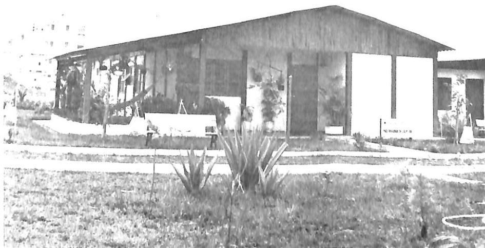
Este modelo da Indústria Bahiana de Lajes é o Vera Maria, construído com painéis pré-fabricados em concreto armado
