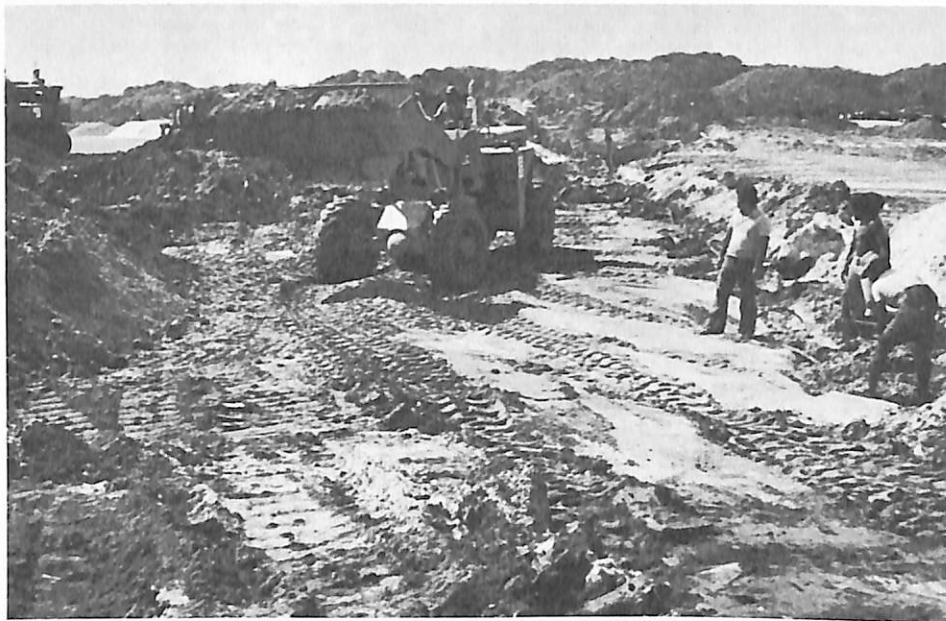
Máquinas operando na remoção de material inservível no pátio de estacionamento de pequeno porte
