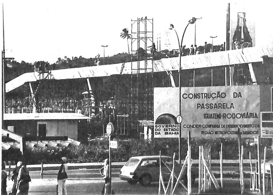
Para agilizar o cronograma, a obra está sendo executada em vigas pré-moldadas e protensão no local
