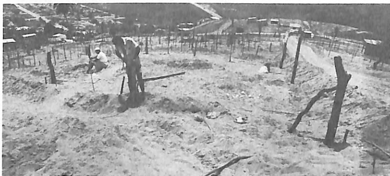
Lotes urbanizáveis em fase de preparação a fim de que possam ser posteriormente ocupados
