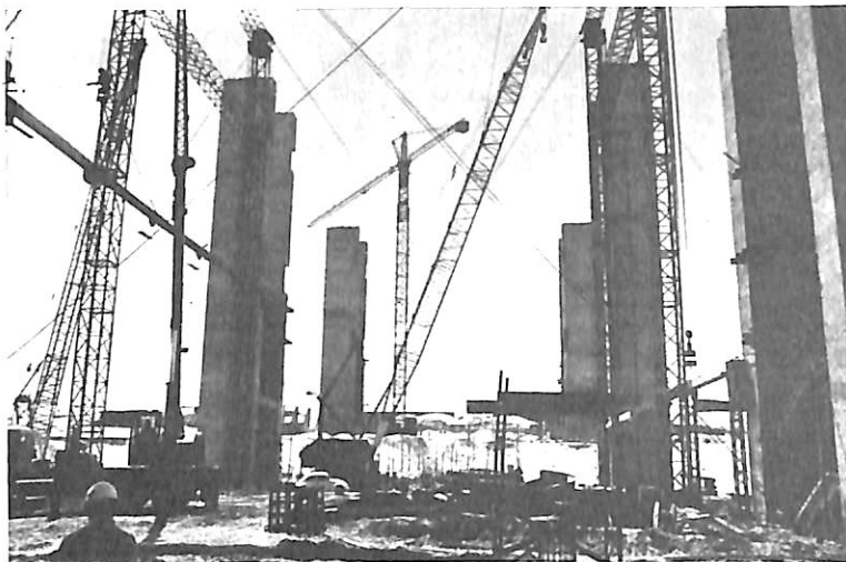
Máquinas e equipamentos operando em uma das etapas das obras do Centro de Convenções
