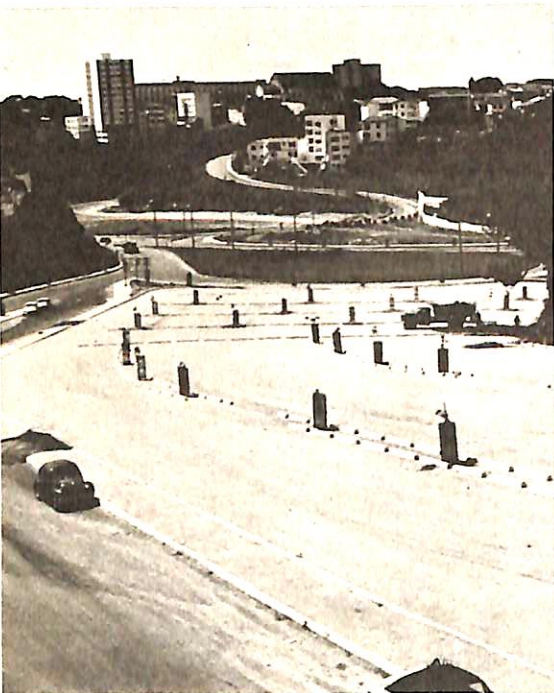
Enfim, no Vale dos Barris, uma providência há tempos requerida pela cidade: um amplo estacionamento em área paisagisticamente tratada.
