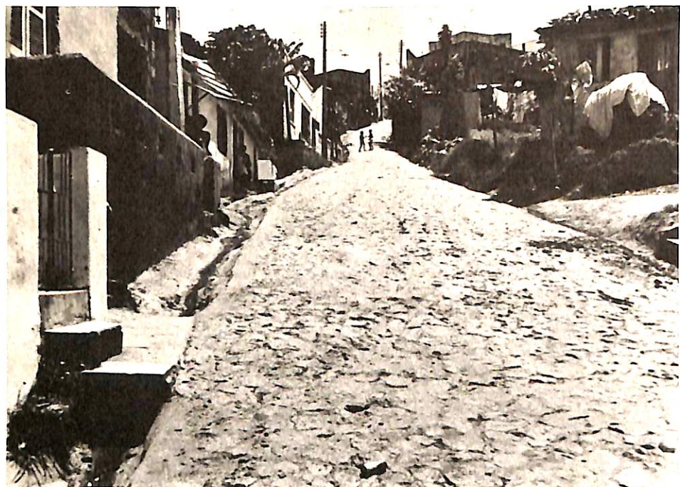
Falta de rede de esgotos e calçamento de ruas é um sintoma que está exigindo soluções imediatas
