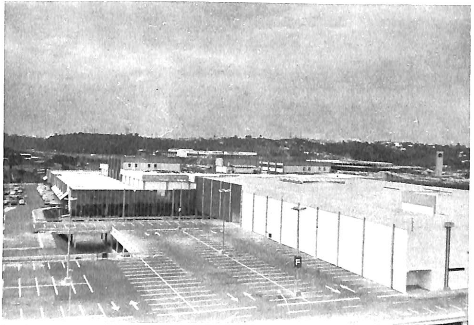
Importante nas obras de ampliação foi o critério adotado pela empreiteira para cumprir o cronograma
