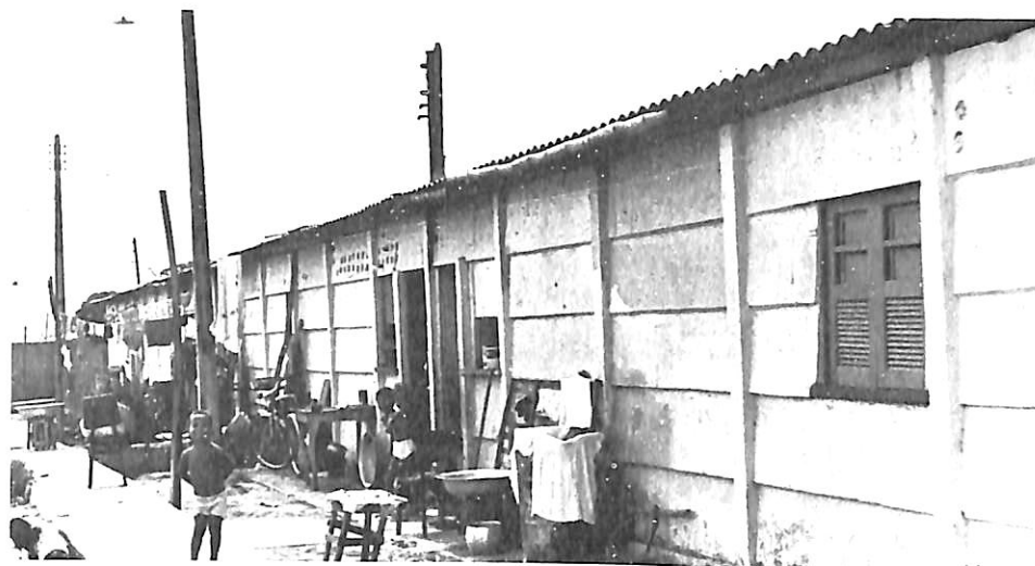
Na fazenda Sete de Abril, as casas de emergência construídas para atender aos desabrigados das chuvas
