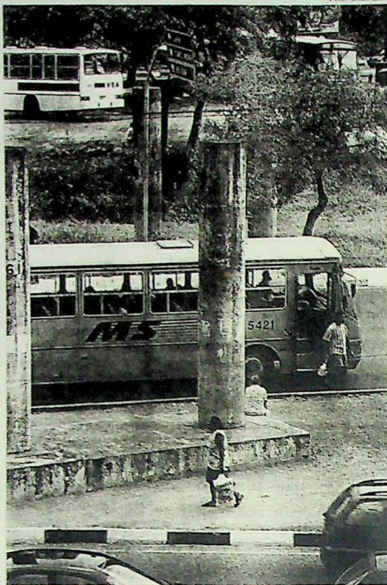
Na Praça João Mangabeira, esqueletos de obra são retrato do desperdício
