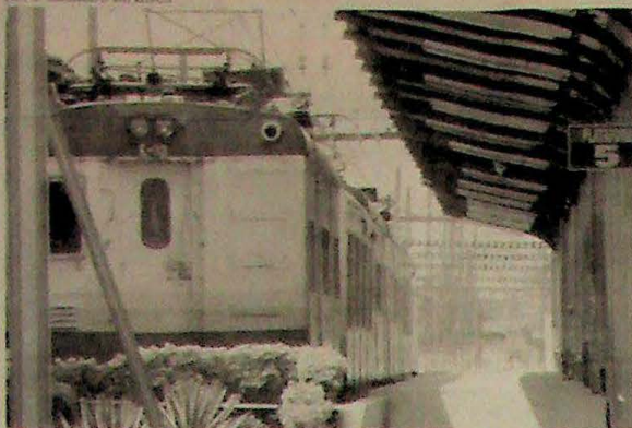
▲ Na Estação da Calçada, os trens passam por reformas
