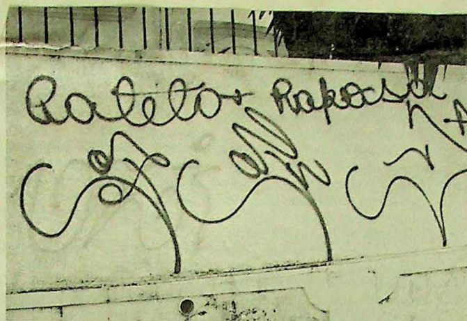
Fachadas e monumentos são o alvo predileto dos pichadores
