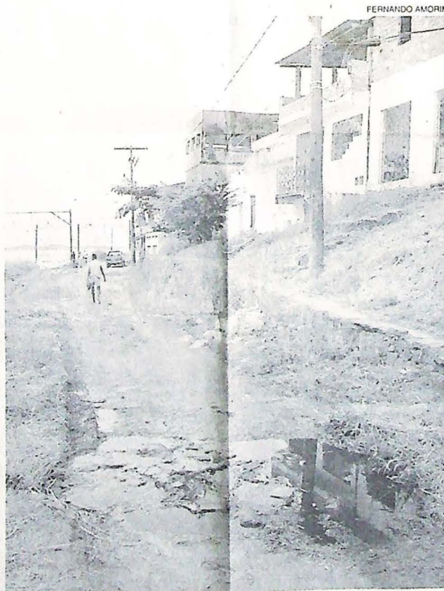
Obras inacabadas transtornam a vida dos moradores
