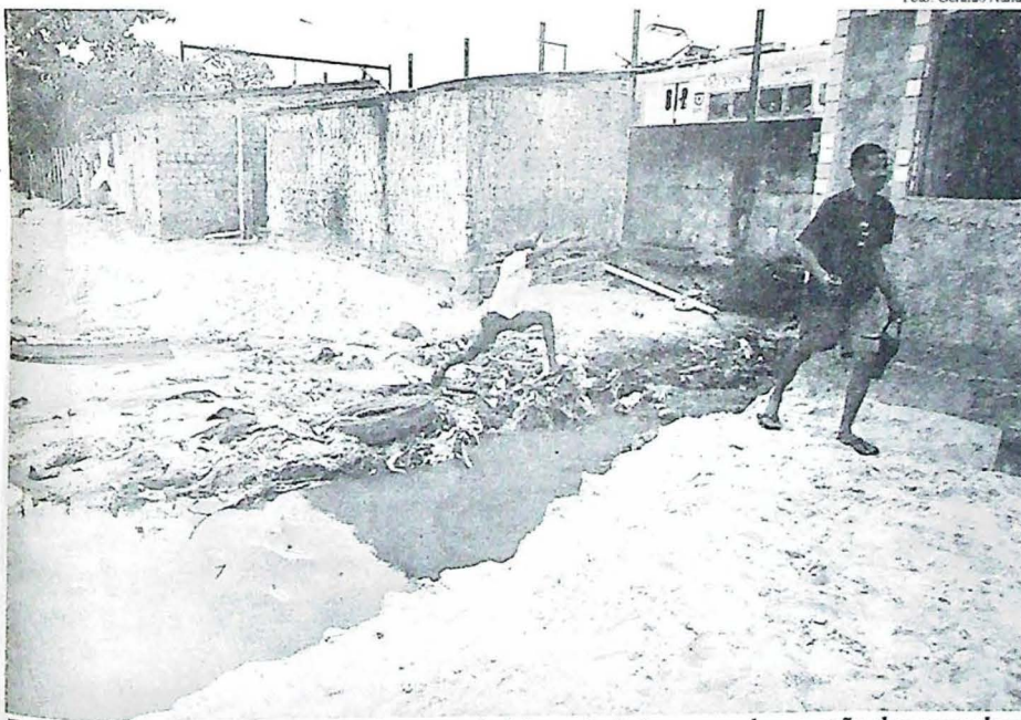
Esgotos correndo a céu aberto exigem verdadeiras ginásticas para locomoção dos moradores
