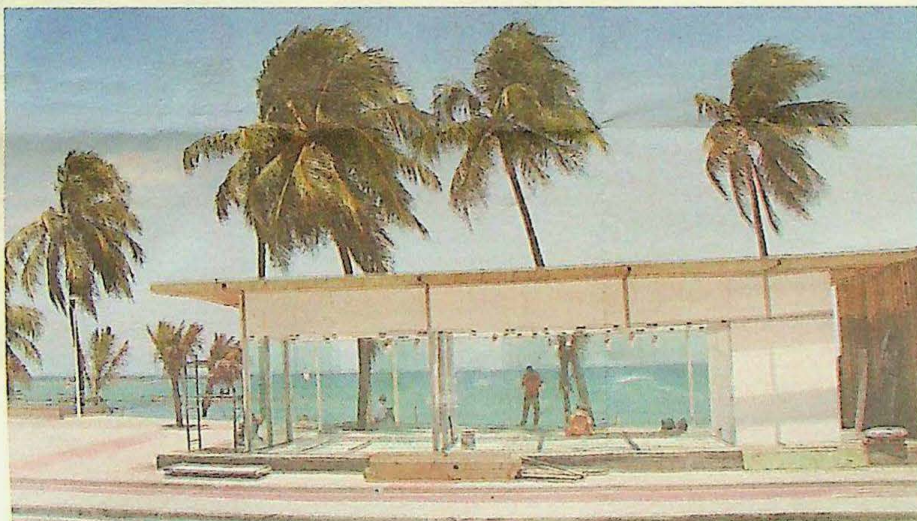
Novos quiosques, de vidro e madeira, estão terminando de ser instalados. Serão 13 entre Itapuã e Piatã
