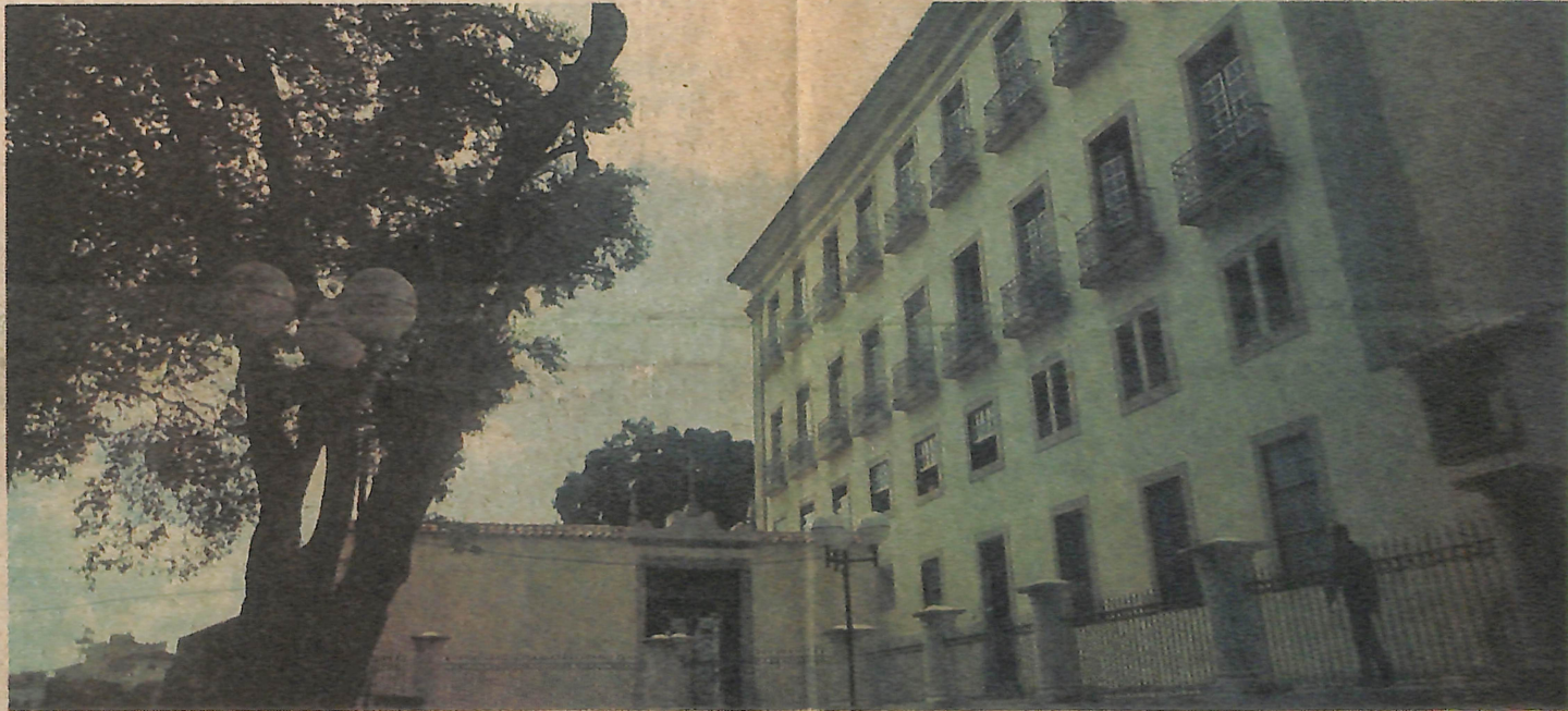
A fachada do mosteiro de São Bento guarda histórias de um Brasil Colônia, marcado através das lápides que ali existem
