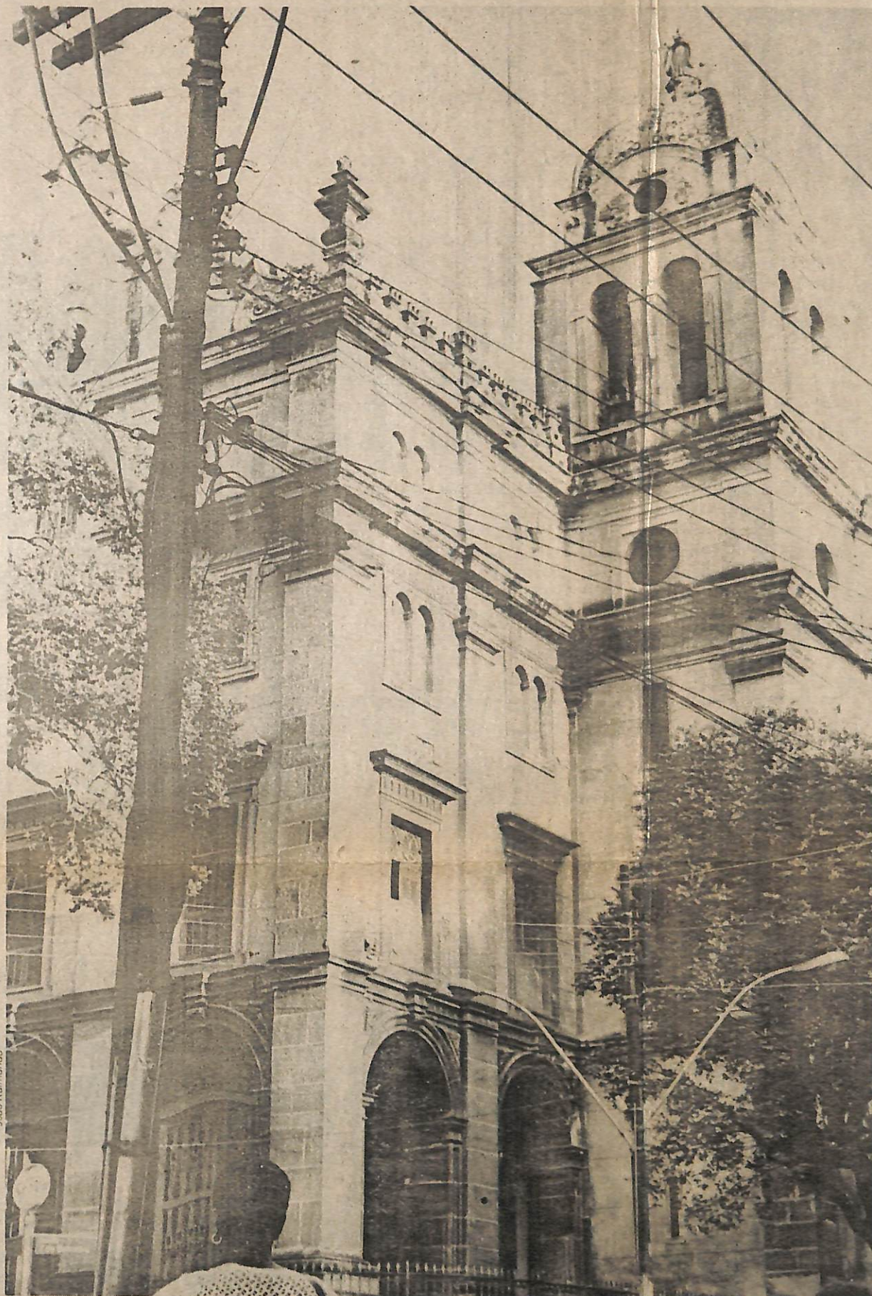
O conjunto arquitetônico do Mosteiro foi uma das primeiras construções em Salvador
