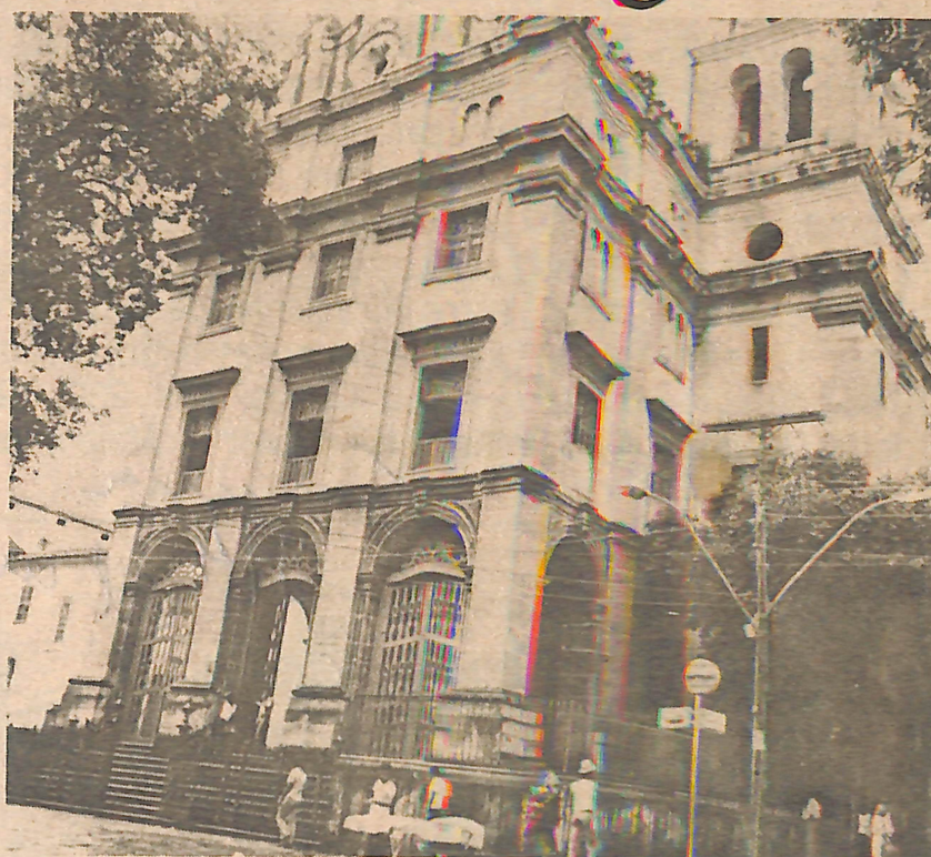
Além dos gradis do mosteiro, outros monumentos da cidade estão destruídos
