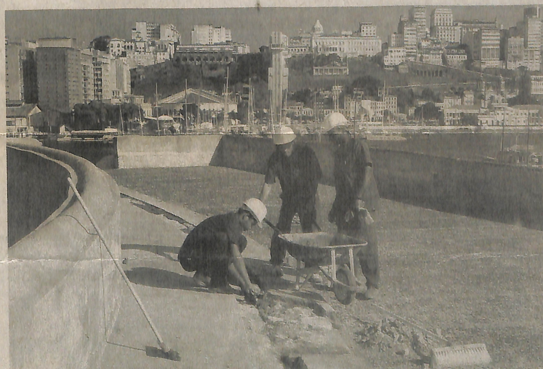
Equipe de operários recompõe a calçada localizada no anel externo da edificação
