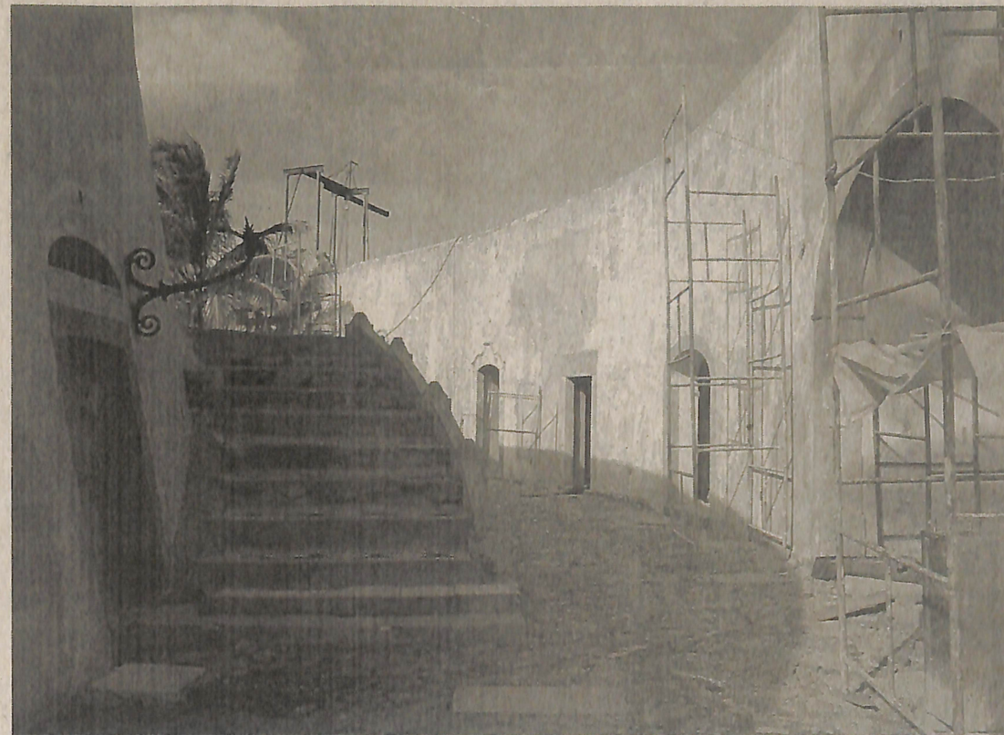
Andaimes foram montados no local para o serviço de pintura da parte interna do forte
