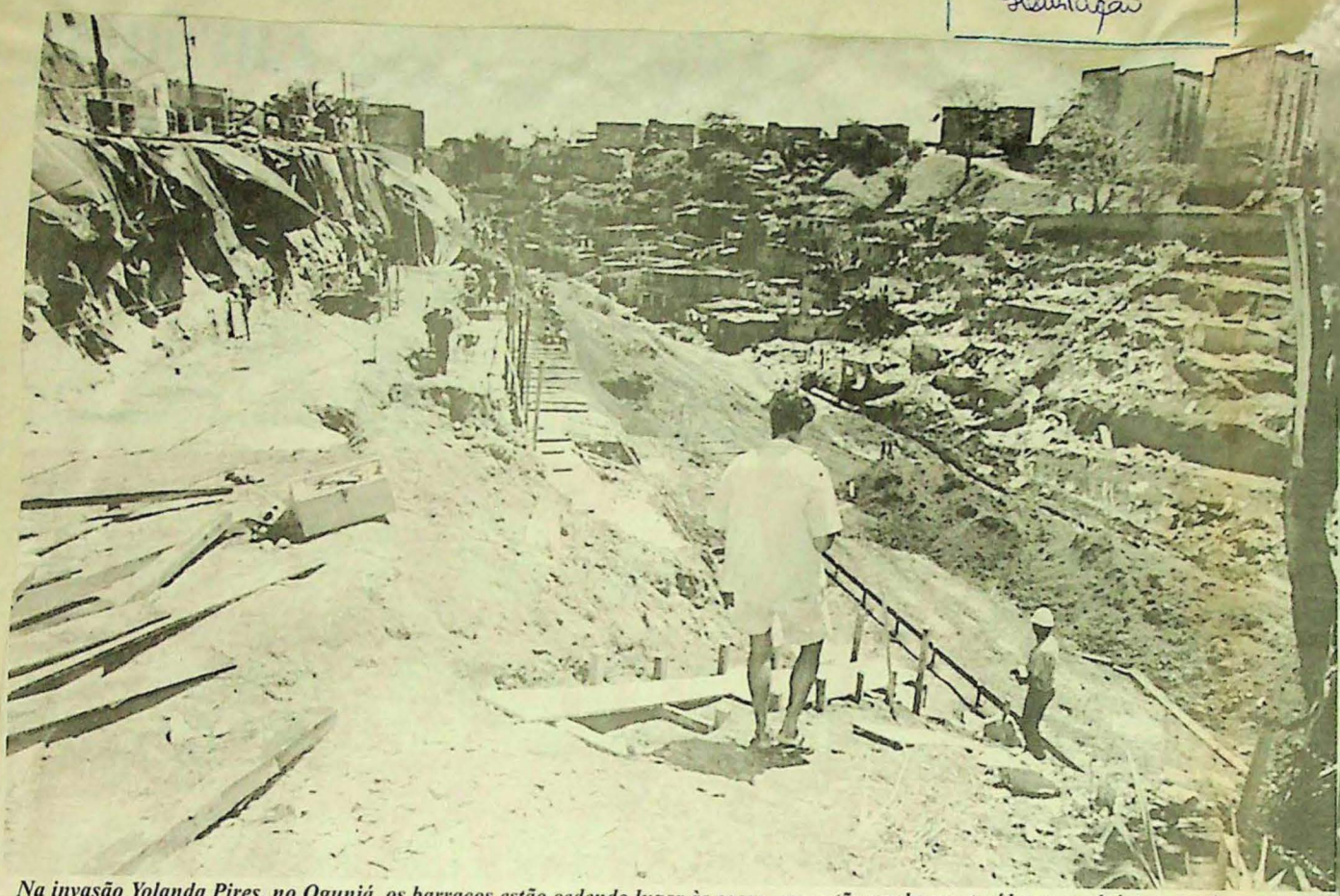
Na invasão Yolanda Pires, no Ogunjá, os barracos estão cedendo lugar às casas, que estão sendo construídas para abrigar os antigos invasores
