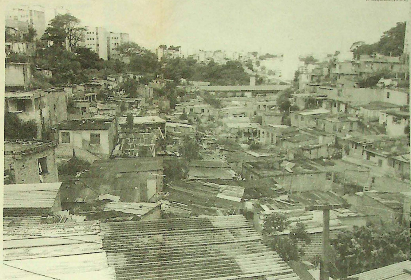
Na Invasão Yolanda Pires os barracos vão dar lugar à construção de 370 casas com dois pavimentos para os moradores do lugar
