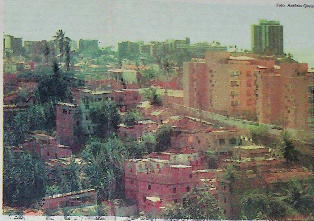
Na invasão do Alto de Ondina, construções de dois e três andares, ao lado de prédios de luxo
