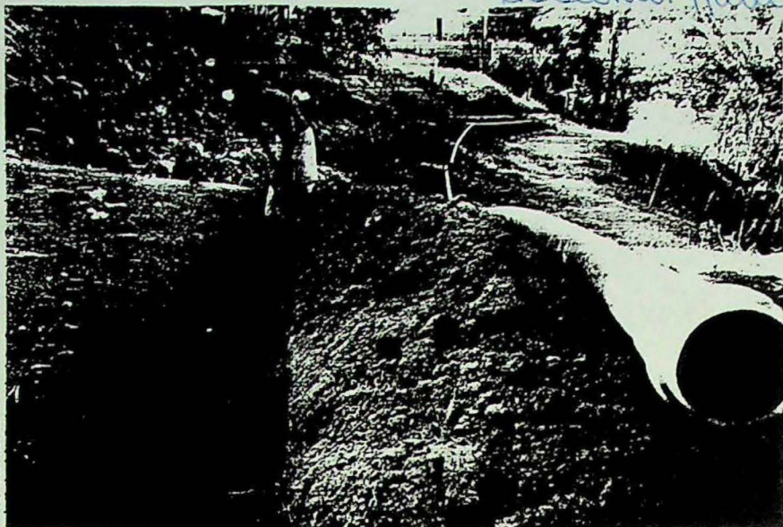
Operários da Embasa remanejaram a tubulação que provocou o deslizamento e matou cinco pessoas
