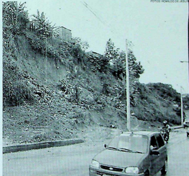
Uma encosta desabou na Avenida Suburbana, ameaçando vidas e o trânsito
