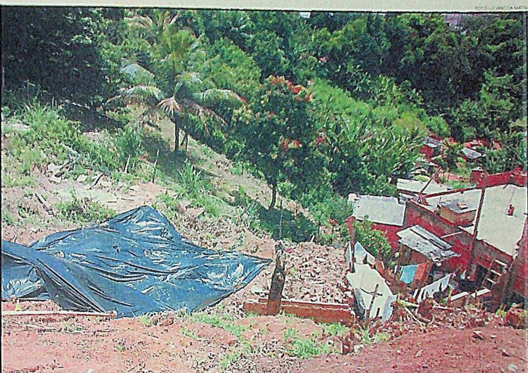
Na 3ª Etapa de Castelo Branco, as únicas ações preventivas foram a retirada de parte da vegetação e colocação de uma lona rasgada
