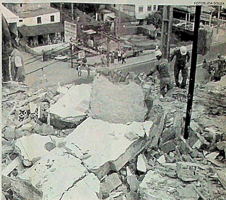
Demolição de imóveis em área de risco é fundamental para reabertura da Avenida Vale do Ogunjá
