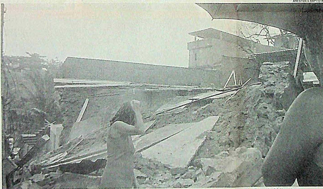
Parte da casa de Raimundo Nonato da Paz ficou soterrada após a terra ceder em um barranco na Estrada Velha do Aeroporto
