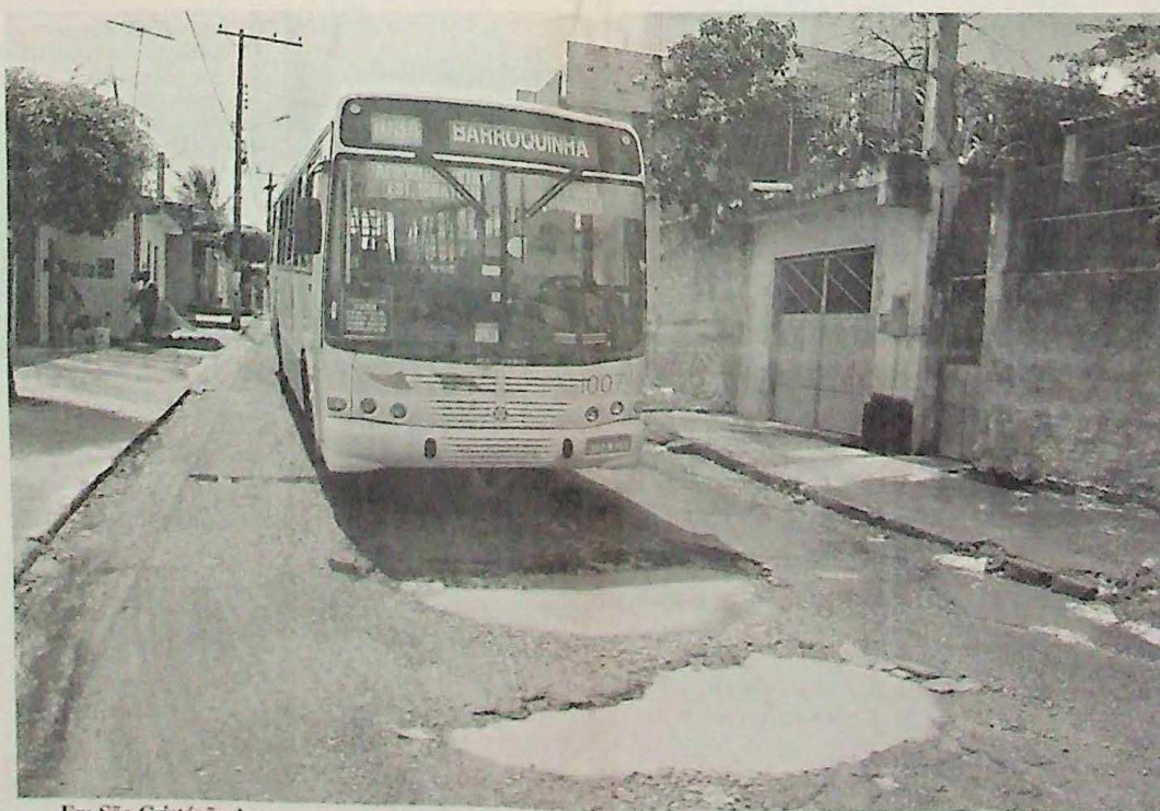
Em São Cristóvão, buracos atrapalham o tráfego de veículos e danificam os carros de quem precisa passar pelo local
