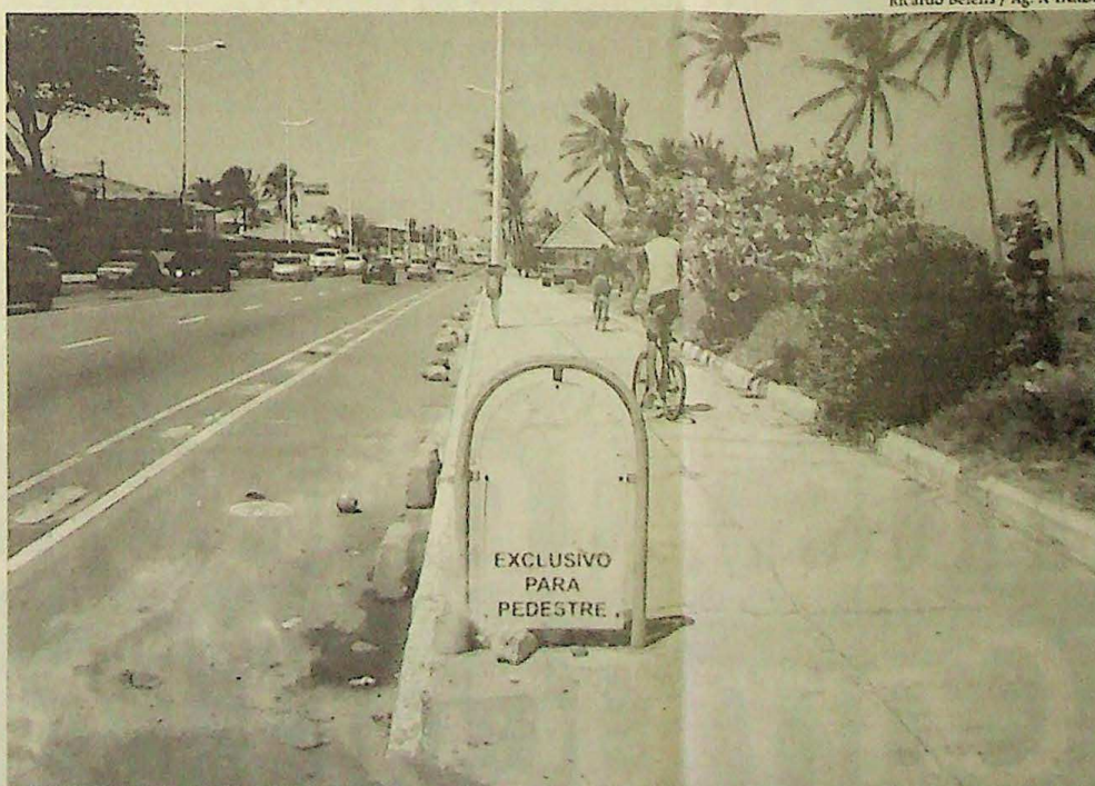
Com a área asfáltica desprotegida, ciclista usa espaço destinado a pedestres em Placaford
