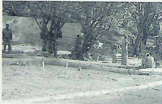
As obras da nova praça estão em ritmo acelerado
