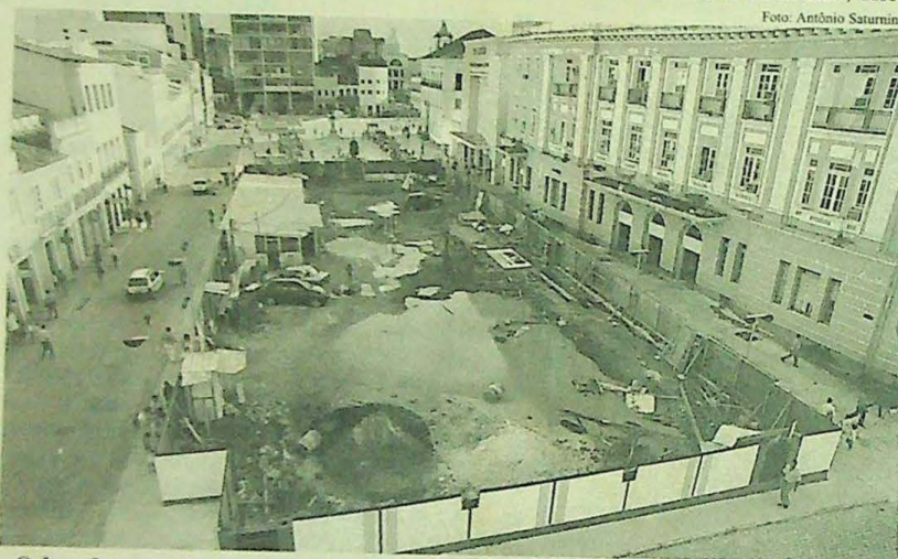
O local, cercado por tapumes, sediará o Memorial de Fundação da Cidade
