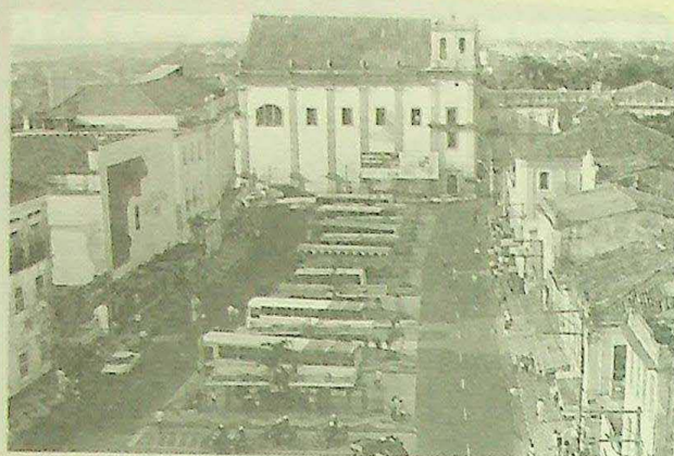
As obras vão incluir a criação de um memorial
