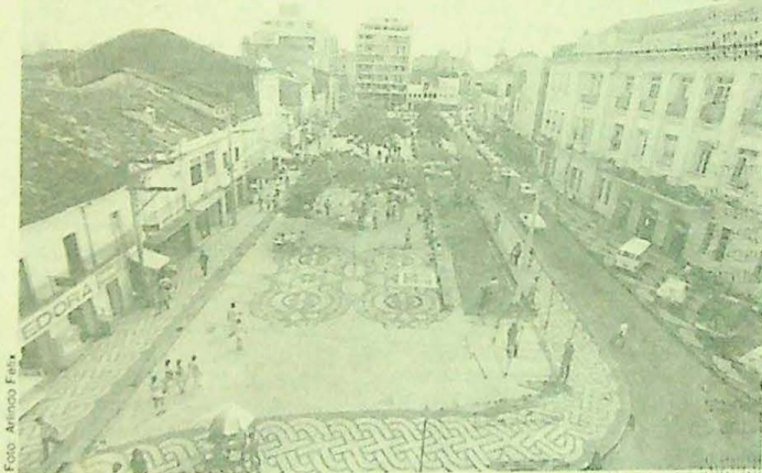
Os comerciantes da Praça da Sé pediram o fim do calçamento
