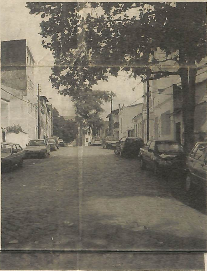
Falta manutenção à pavimentação em paralelepípedos
