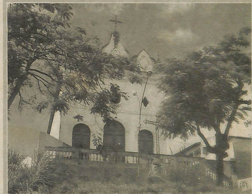
Moradores sonham com obras de recuperação da velha igreja
