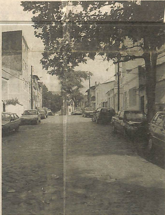
Falta manutenção à pavimentação em paralelepípedos
