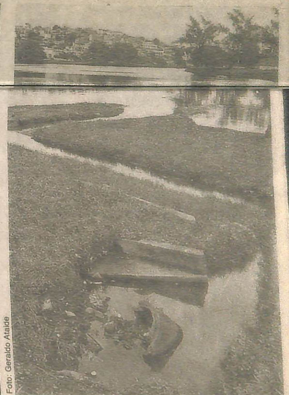
Esgotos e manilhas quebradas atestam o abandono.
