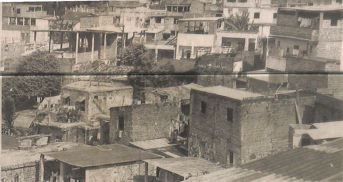
Lajes e paredes sem reboco contrastam com os altos e ricos edifícios da Pituba e Itaigara
