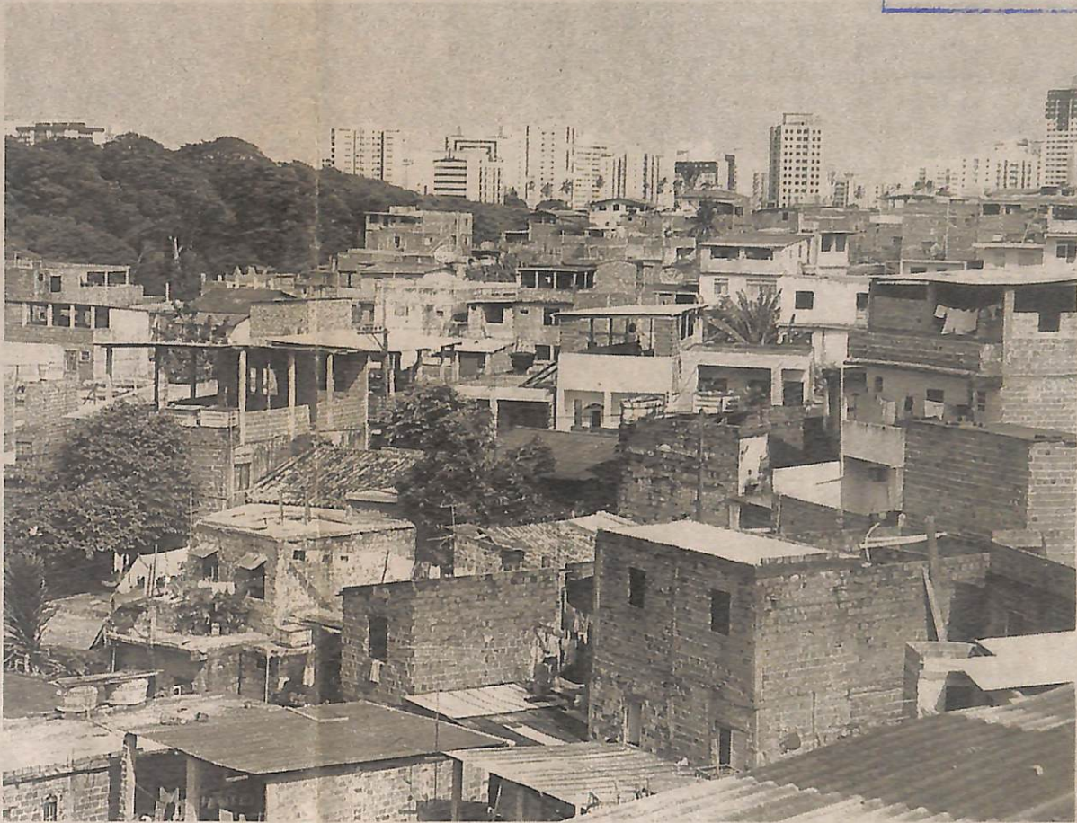
Lajes e paredes sem reboco contrastam com os altos e ricos edifícios da Pituba e Itaigara
