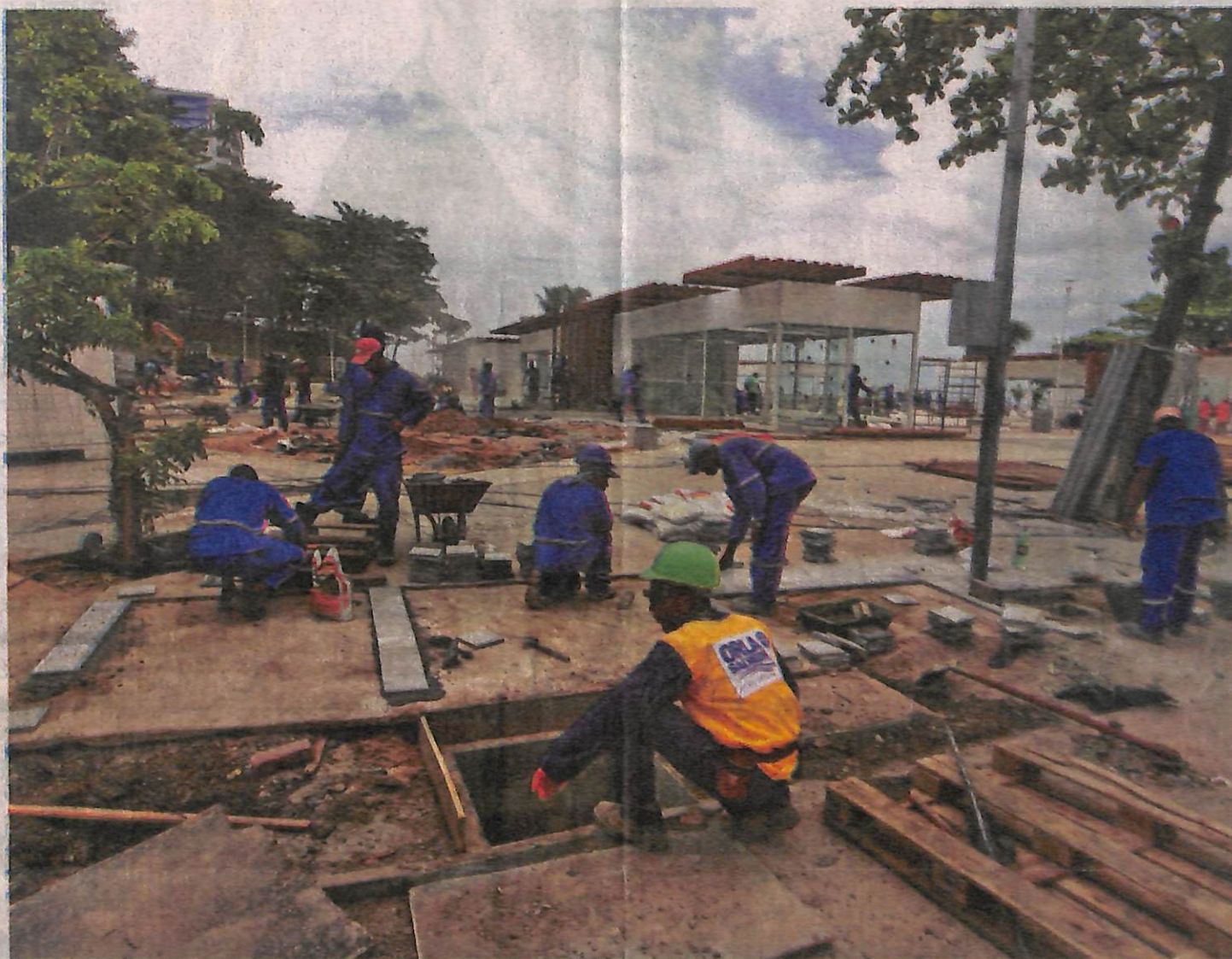
Operários trabalham em regime de 24 horas para garantir o término das intervenções no bairro até esta sexta
