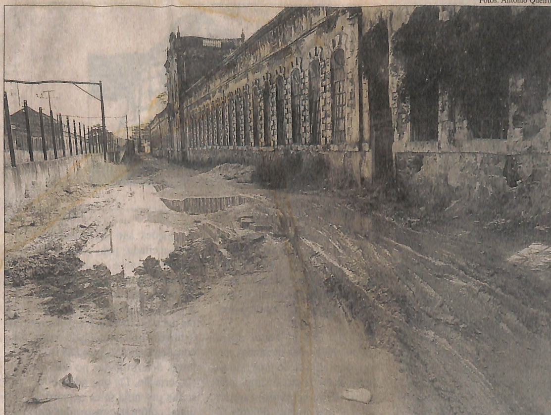
A falta de infra-estrutura e saneamento fica mais evidente agora, no período de chuvas
