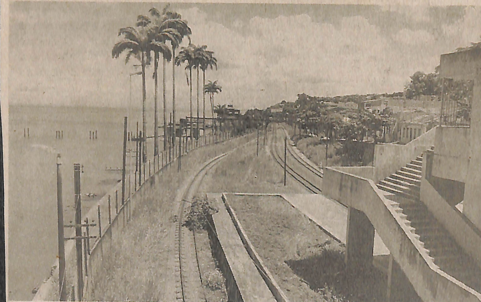
Linha férrea teve no passado maior significado no transporte de passageiros
