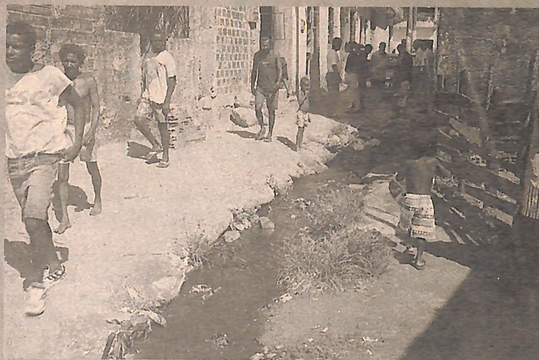
Excesso de buracos é um dos problemas de Plataforma
