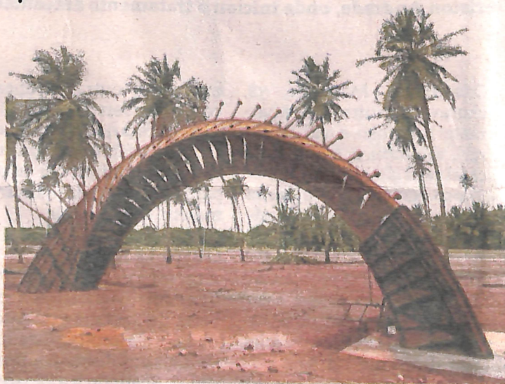
Estrutura de metal chama a atenção na obra de Piatã
