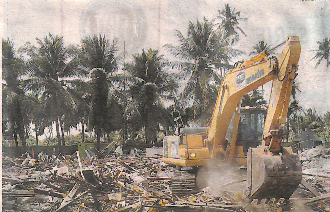
Retroescavadeira derruba estrutura onde funcionava Bali Beach para início de requalificação na orla de Piatã
