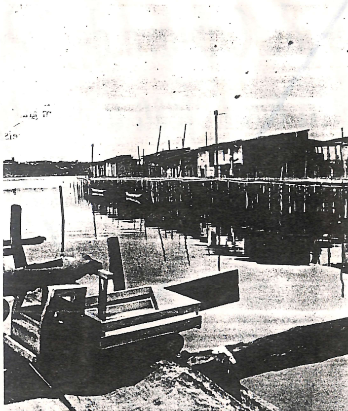
As palafitas aceleraram o processo de degradação
